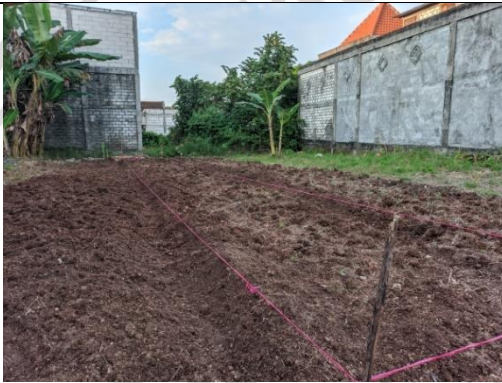
Gambar 3 membuat drainase Sumber : Dokumentasi Pribadi, Mei 2021
