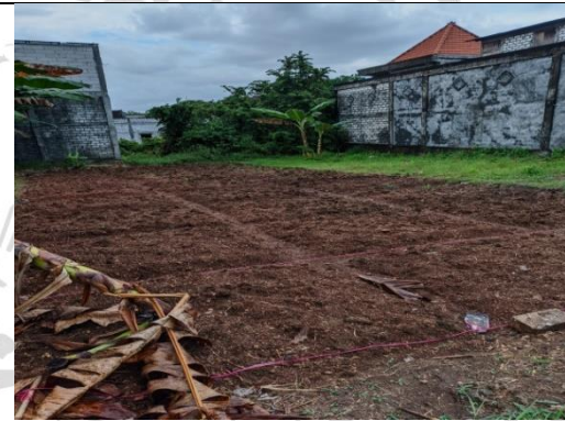
Gambar 4 Membuat Drainase Sumber : Dokumentasi Pribadi, Mei 2021
