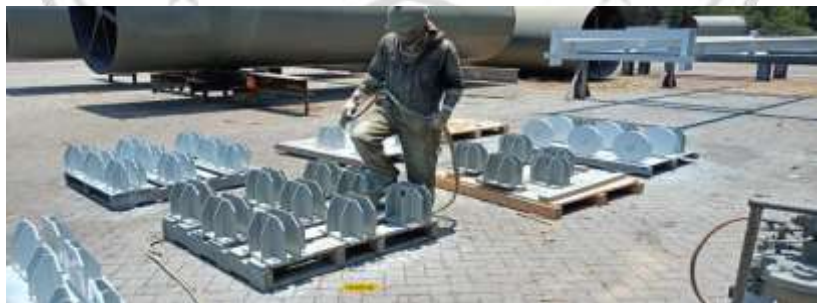
Gambar Proses pengecatan SAP
