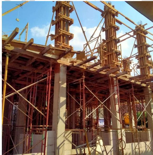
Gambar 2.1 Bekisting Konvensional
