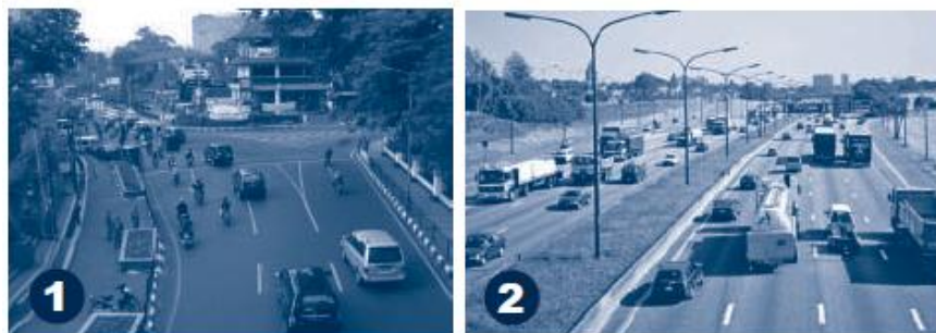
Gambar 2.6 Jalan arteri dan jalan tol
