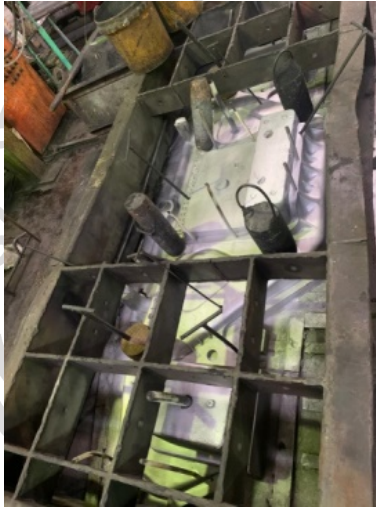
Gambar 2. 6 Pemasangan sleeve dan gating system
