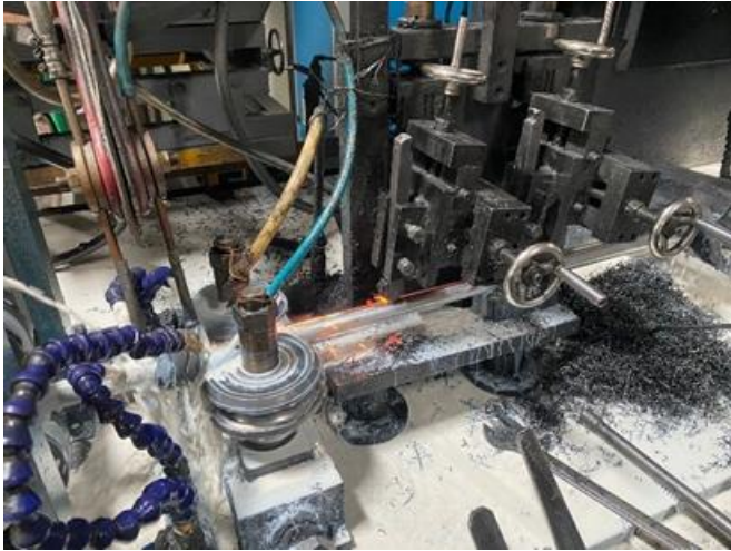
Lampiran 4 Mesin Cooling Tank Sumber: Dokumentasi pribadi
