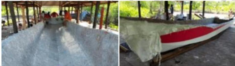
**Gambar 2.3** Proses laminasi kulit lambung kapal fiberglass dan Hasil Laminasi Lambung Kapal [7]
