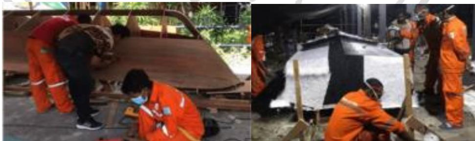
**Gambar 2.2** Pembuatan Cetakan Kayu dan Lamonasi Cetakan Kapal Fiberglass [7]
