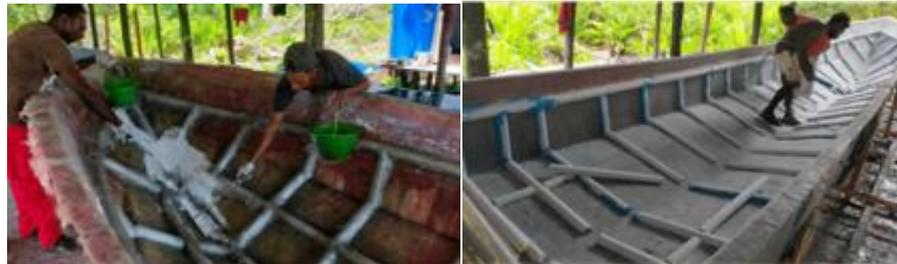
**Gambar 2.4** Proses penataan Core Material penguat dan Laminasi konstruksi penguat Lambung Kapal [7]
