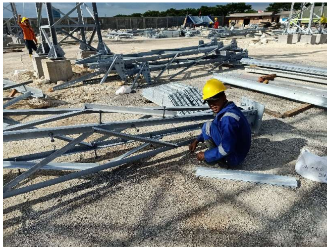
Gambar 8. Perakitan Rangka
