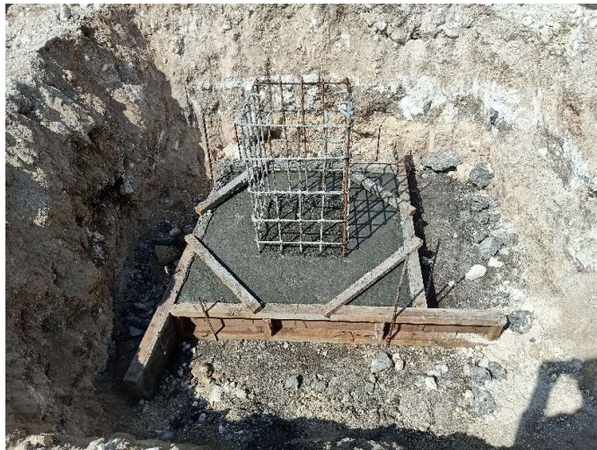
Gambar 2. Pondasi Foot plat
