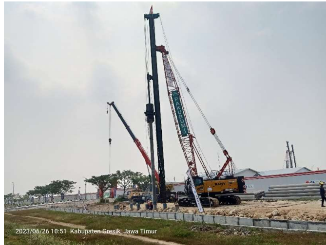
Gambar 1. Proses pemancangan
