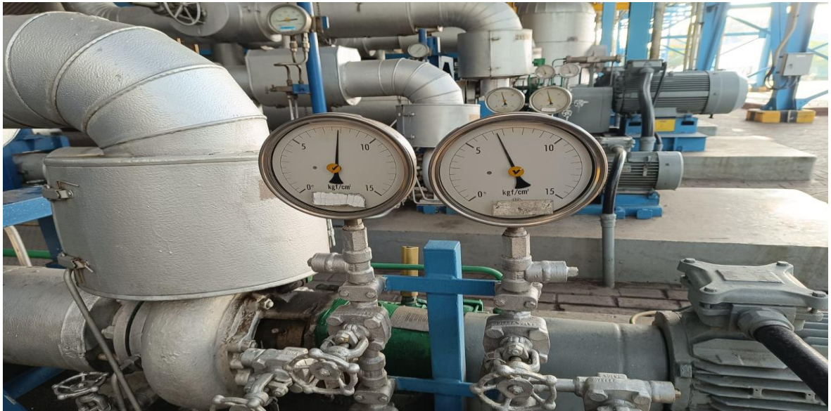
Lampiran 5: Gambar Indikator Tekanan Suction dan Tekanan Discharge.
