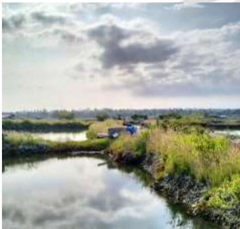
Saluran pipa aliran air
