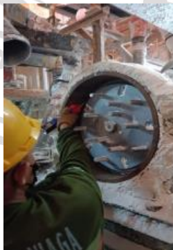
Lampiran 6. Perbaikan Mesin Hummer Mill Crusher
