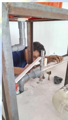
Lampiran 9 Pemasangan shell akrilik
