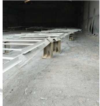
Lampiran 12 Proses pengecatan di dalam ruangan
