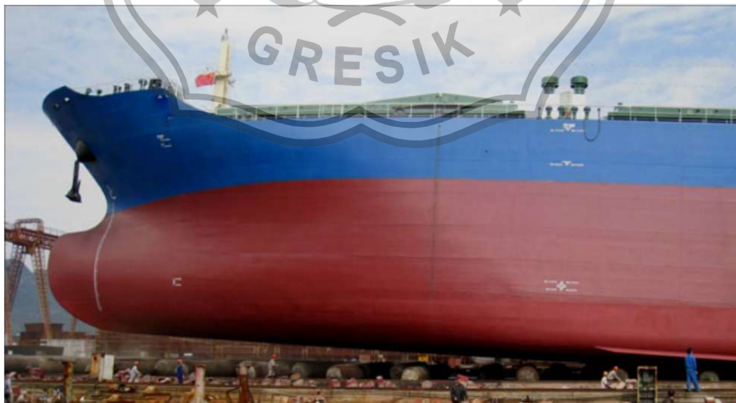
Gambar 3. 2 Kondisi Peluncuran, Bagian Depan Kapal Terangkat Sumber: http://www.eversafe-marine.com
