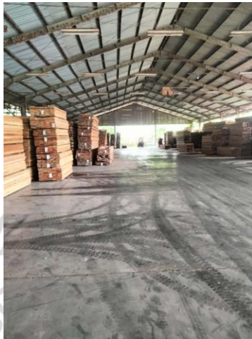
Lampiran 1 Kondisi gudang PT. Inhutani UMI 1 Gresik
