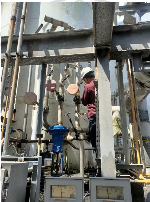
Lampiran 1: Dokumentasi membantu pemasangan safety valve
