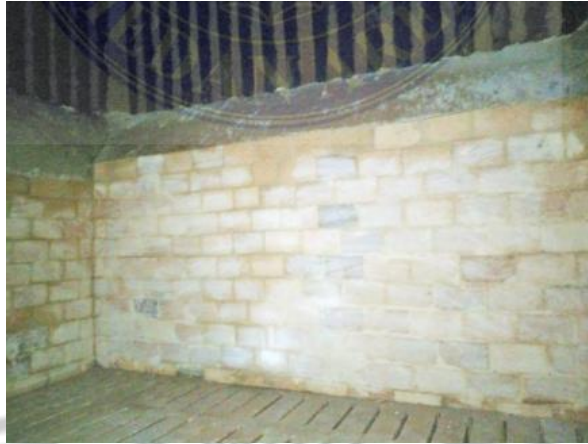
Gambar 2. 6 Lapisan refraktori batu bata sumber (HASIBUAN J., 2023)
