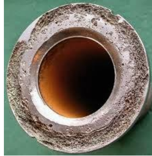
Gambar 2. 3 korosi celah pada sam
