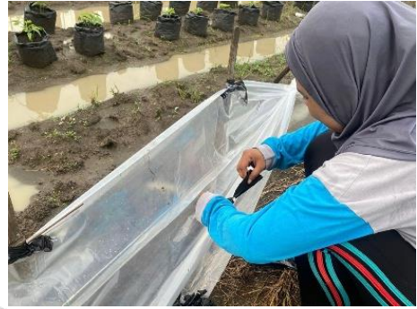
1. Pemasangan pagar plastik
