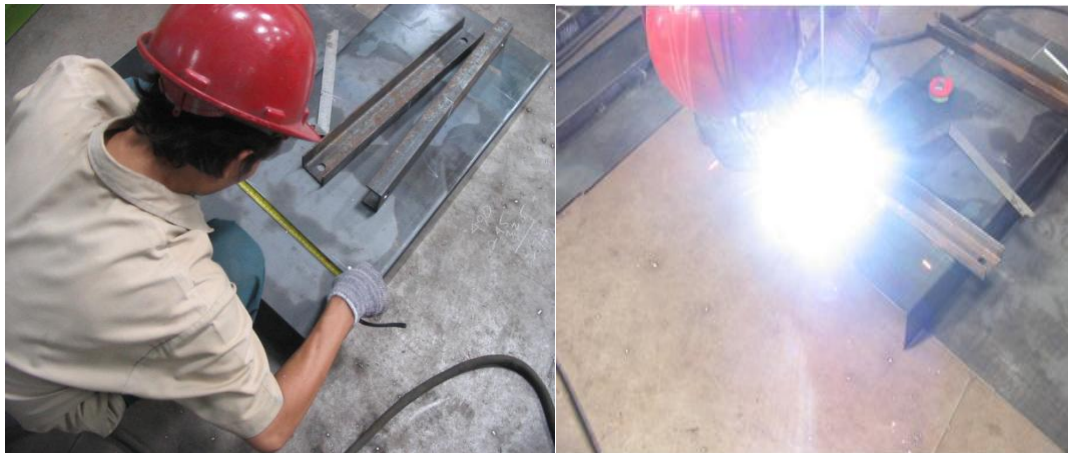
Gambar 1.1 Sikap kerja Operator Las di Bengkel UD.Sumber Anyar
