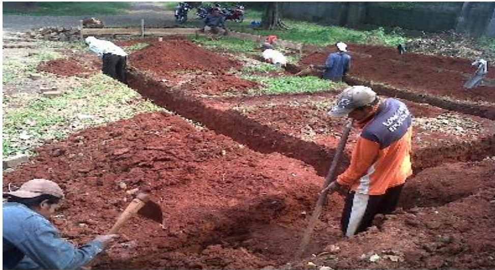
Gambar 2.1 Pekerjaan Persiapan, Galian Dan Urugan
