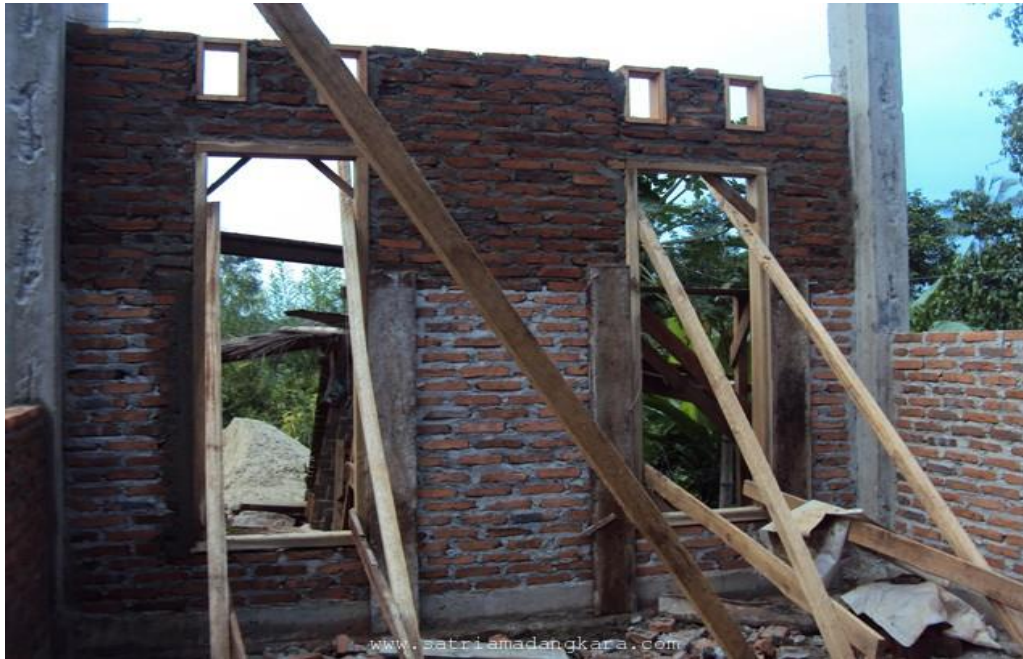
Gambar 2.7 Pekerjaan Kusen, Pintu Dan Jendela
