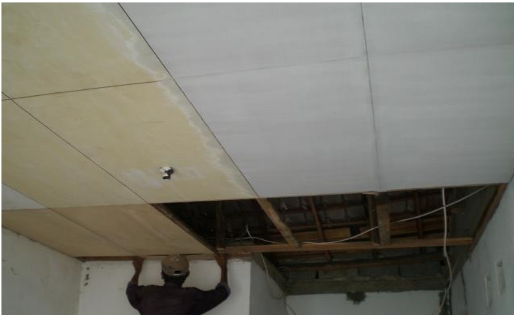
Gambar 2.6 Pekerjaan Plafon
