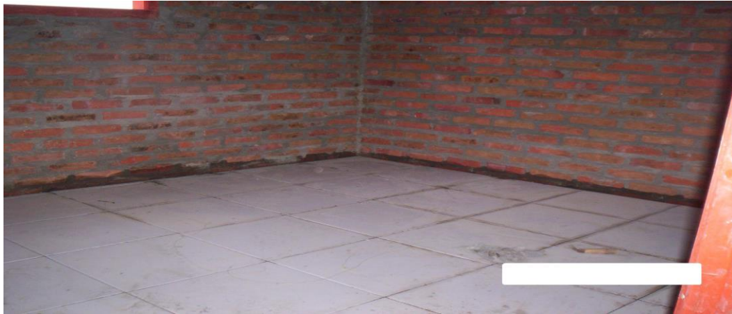
Gambar 2.4 Pekerjaan Lantai Dan Dinding
