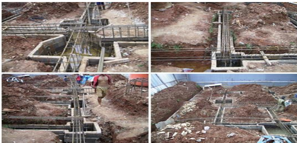
Gambar 2.2 Pekerjaan Pondasi Dan Beton
