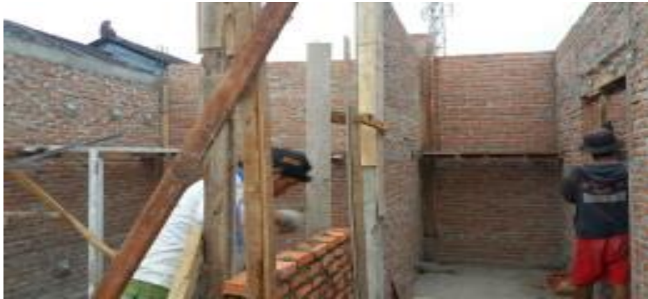
Gambar 2.3 Pekerjaan Pasangan Dan Plesteran
