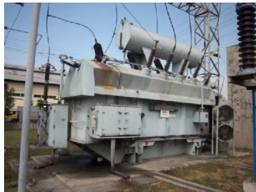
Gambar 3.2 Trafo 1 150/70KV
