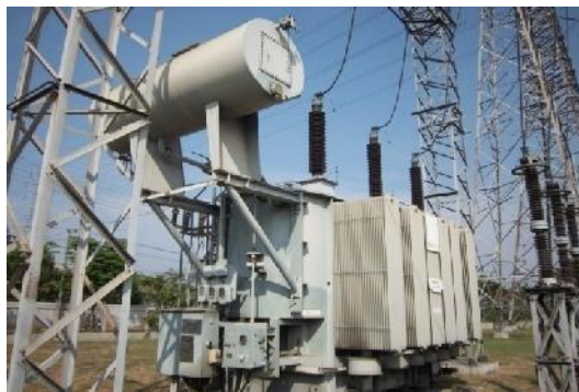
Gambar 3.4 Trafo 3 150/20KV
