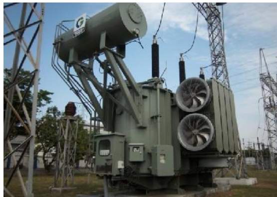
Gambar 3.3 Trafo 2 150/20KV
