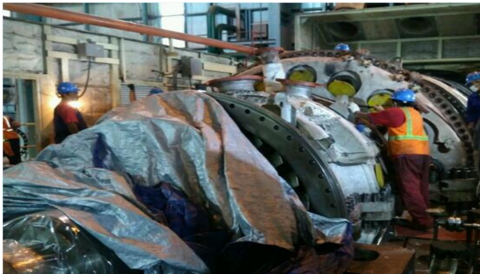
Gambar 2.3 Bentuk Fisik Turbin Gas PLTGU Gresik
