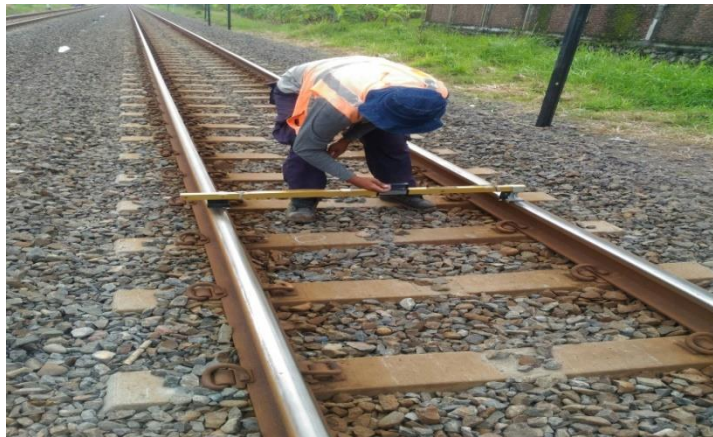
Gambar 1.1 proses pengecekan struktur jalan rel
