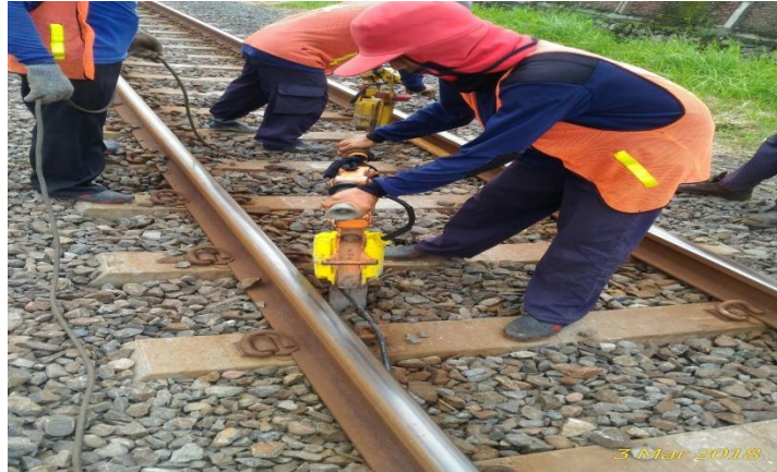
Gambar 1.2 proses pekerjaan menggunakan alat mekanis
