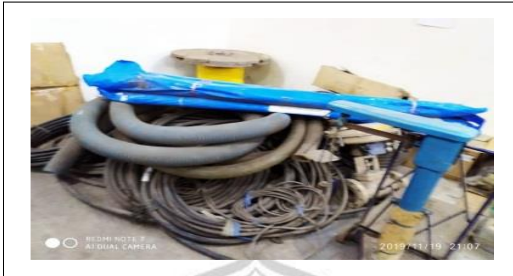
Gambar 1.2 Peletakkan kabel bermacam spesifikasi yang tidak rapi
