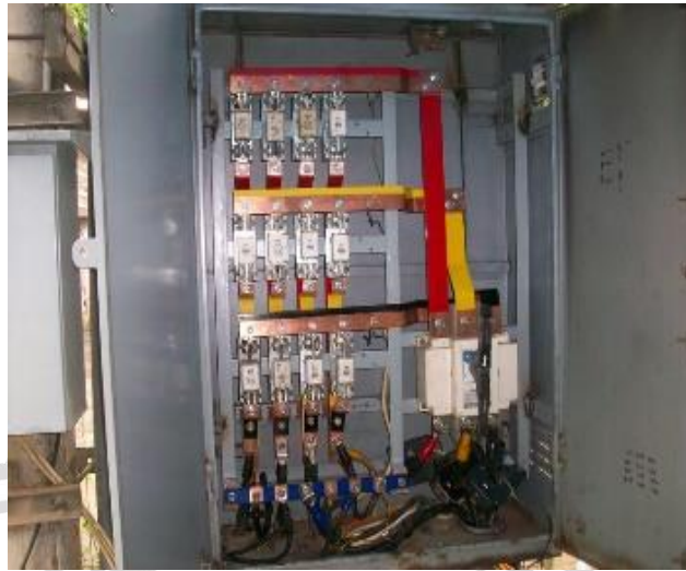
Gambar 2.4 Papan Hubung Bagi Tegangan Rendah
