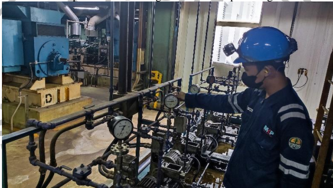
Lampiran 8 Monitoring peralatan injeksi air feed pembangkit
