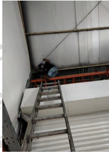
Proses penarikan Kabel Cat 6 server ke PTP
