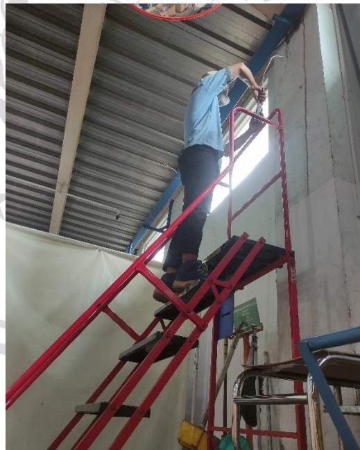
Pemasangan Access Point Unify diarea Gedung C
