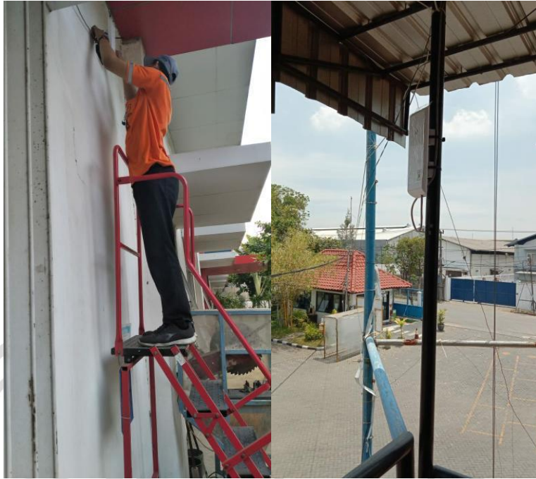
Pemasangan Point To Point dari Server ke Gedung C
